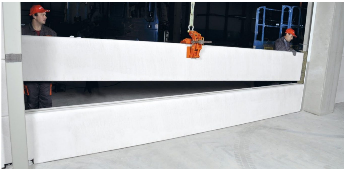
Kuva 3.9 bauroc SEINÄELEMENTIN asennus
