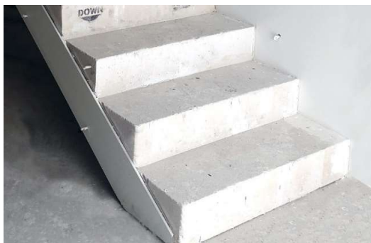
Kuva 3.14 Teräspalkin päälle tuetut bauroc PORRASASKELMAT
