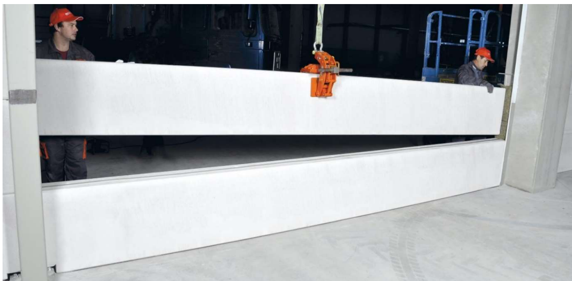
Kuva 3.9 bauroc SEINÄELEMENTIN asennus
