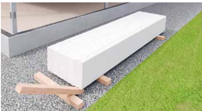
Nostettavan elementin irrottaminen nipusta. Vaihe 1
