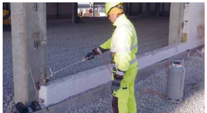
Huurteinen pinta on ennen laastin levitystä lämmitettävä esim. kaasupolttimella
