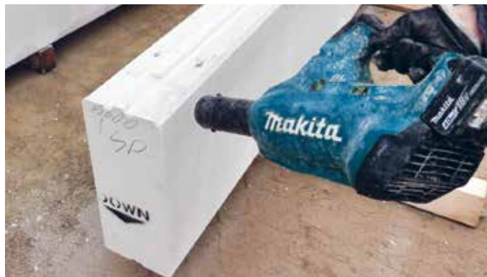
Puhdista elementin pinta jyrsimisen jälkeen irtomateriaalista
