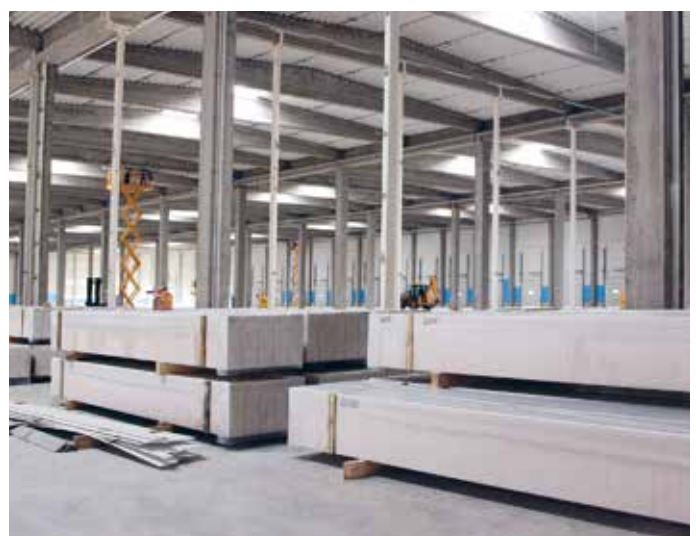
Elementtien varastointi betonilattialle
