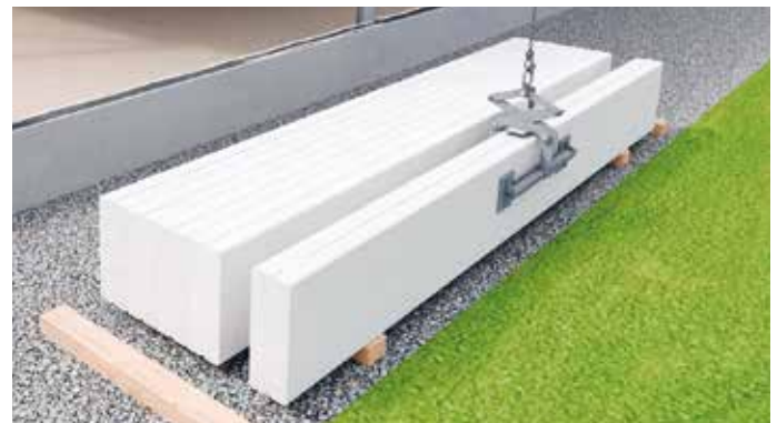
Elementti nostetaan keskikohdasta
