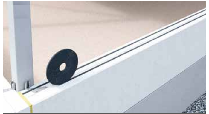
Vaakasauman tiivistysvaihtoehto 2: tiivistysnauha laitetaan urospontiin molemmille puolille
