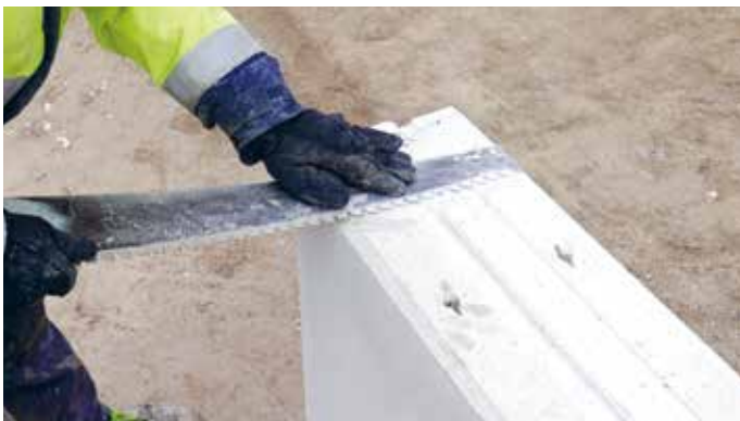
Uran jyrsiminen kiinnitysankkurille
