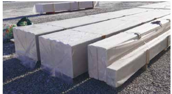
Elementit on suojattava sateelta varastoinnin ja asennuksen aikana.
