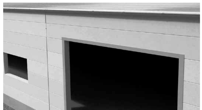
Aukkojen pieliä teräskehys suojaa seinärakennetta
