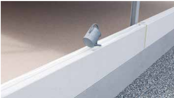
Vaakasauman tiivistysvaihtoehto 1: ohutsaumalaasti levitetään kastelukannulla
